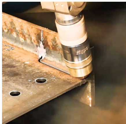
Abbildung 7. Gesteuerter Zuschnitt einer Trägerschnittung
